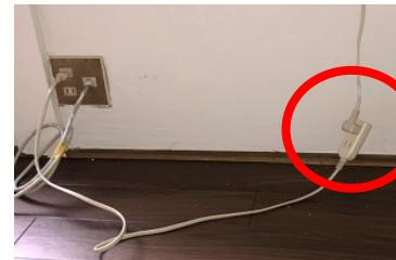
さらに接続部が宙に浮いた状態で使用していると、接続部がゆるんだりするため、接触不良が生じて異常発熱し、発火する危険があります。今すぐやめてくださいね！！
